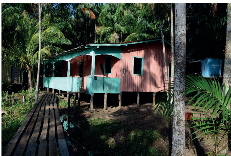
Figura 22 – Uma passarela elevada que leva a uma casa sobre palafitas (Nota: quando a arrumação é alta, a água chega muito abaixo do edifício). Fonte: SCHIFFER, 2017
